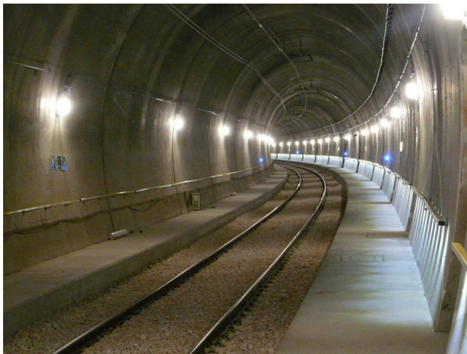
Vista interna della galleria
