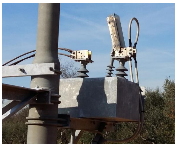
Sezionatore con lama di terra aperta
