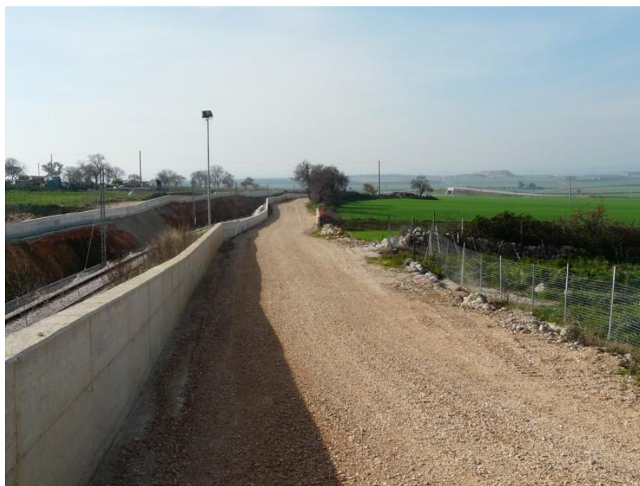
Strada di accesso alla galleria km 16+300
