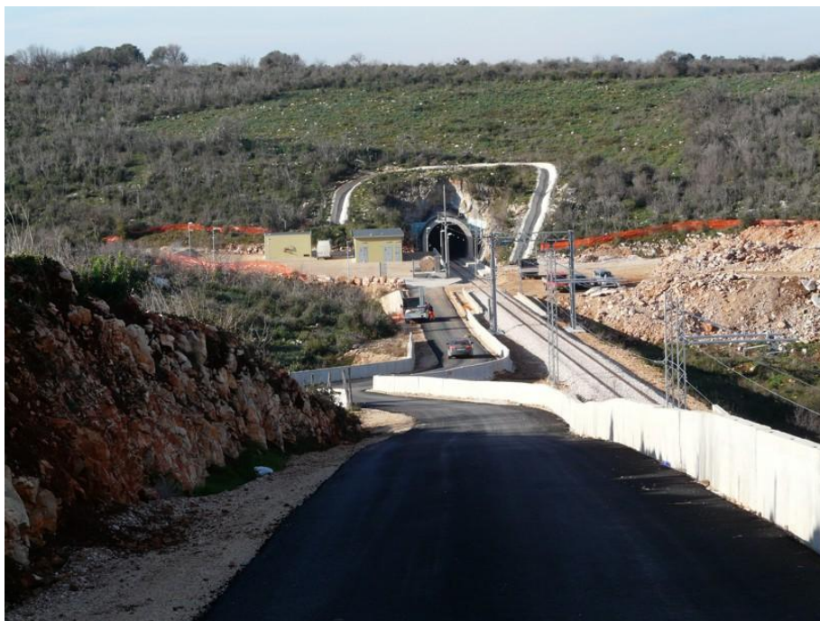
Strada di accesso alla galleria km 19+478
