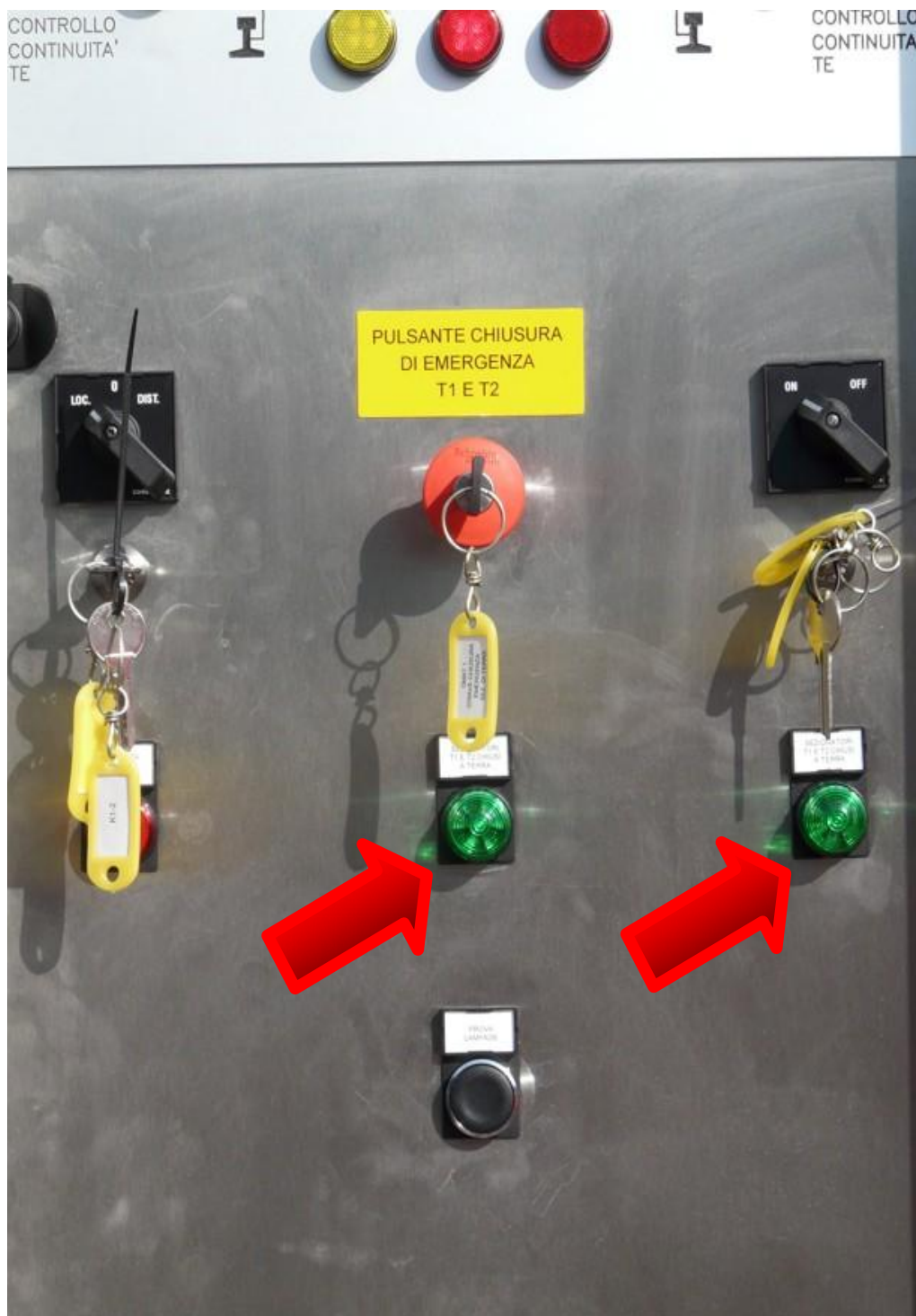
Quadro di manovra, con evidenza delle lampade verdi di segnalazione che, in accensione, consentono l'accesso in galleria in sicurezza
