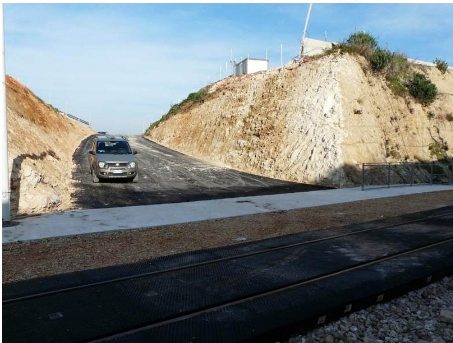
Pavimentazione Strail per l'inversione di marcia mezzi di soccorso
