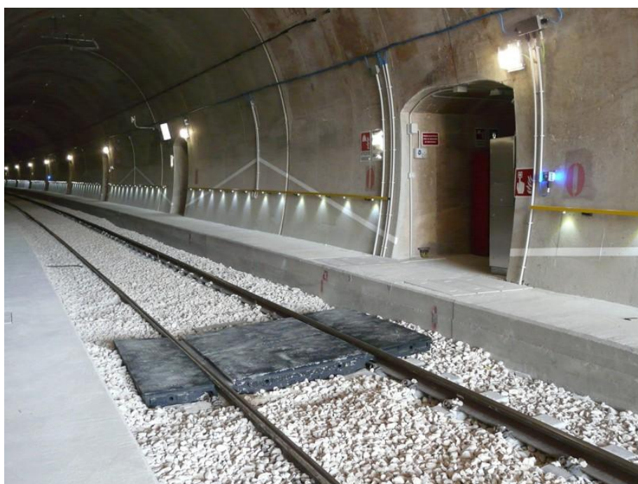
Attraversamento binari interno alla galleria con pavimentazione Strail
