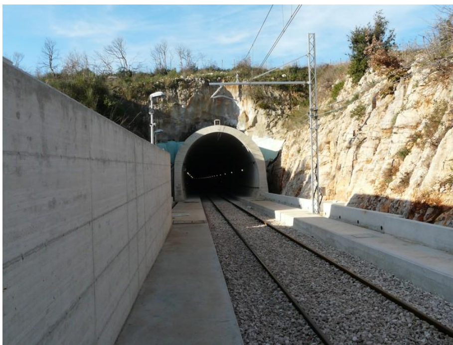
Ingresso galleria km 19+478
