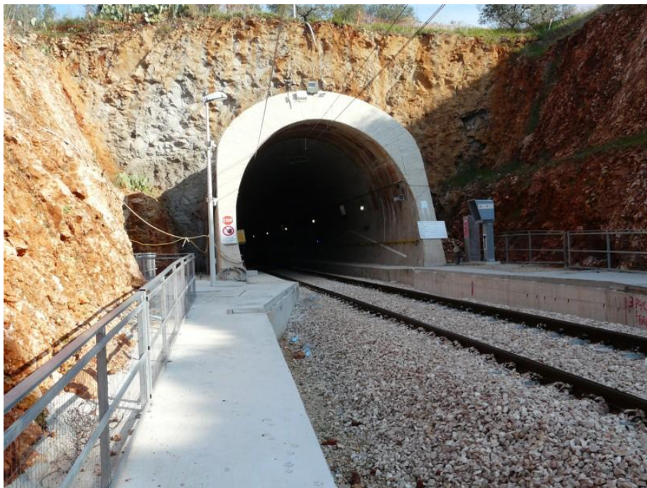
Ingresso galleria km 16+300
