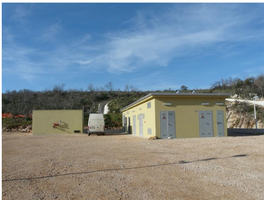
Accesso area tecnica
